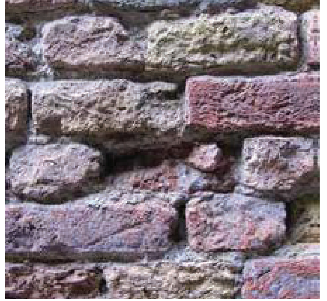
Şekil 5: Tarihi yapılardaki doğal taşlar arasında gelişen derz boşalması.
